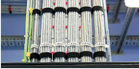
Fixation correcte des câbles verticaux
